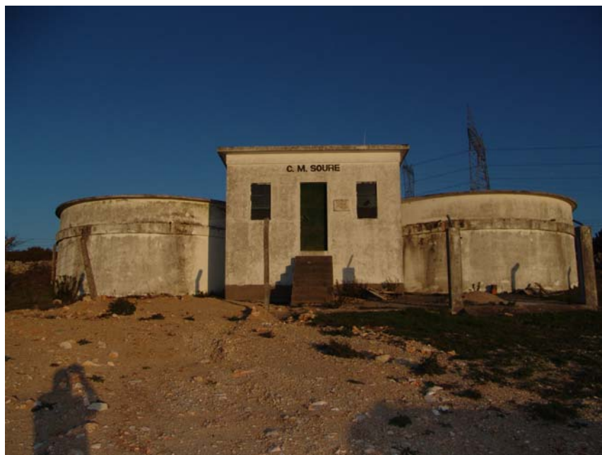
Ponto 19 – Depósito de água (abastecimento público).
