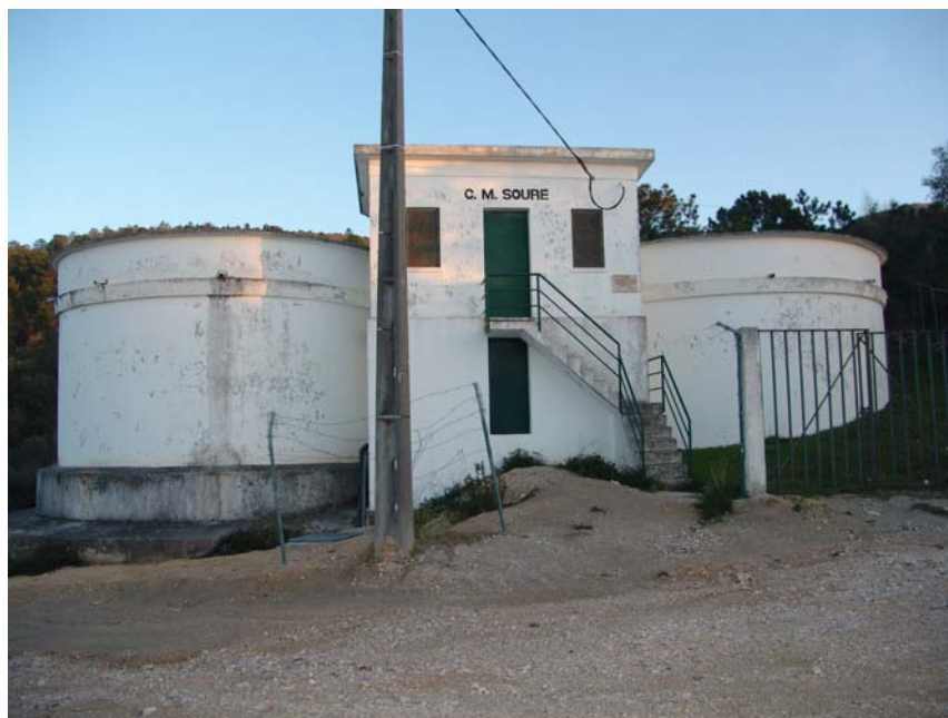
Ponto 17 – Depósito de água (abastecimento público).
