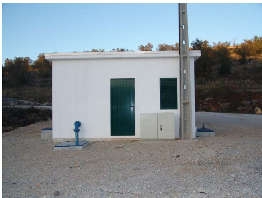
Ponto 18 – Estação elevatória.
